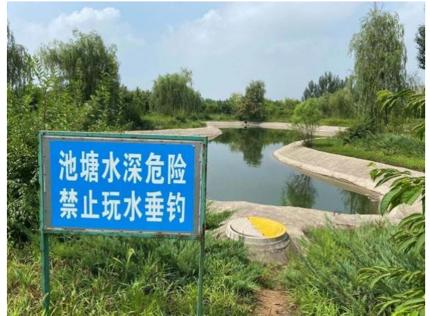
雨水池正常使用中
