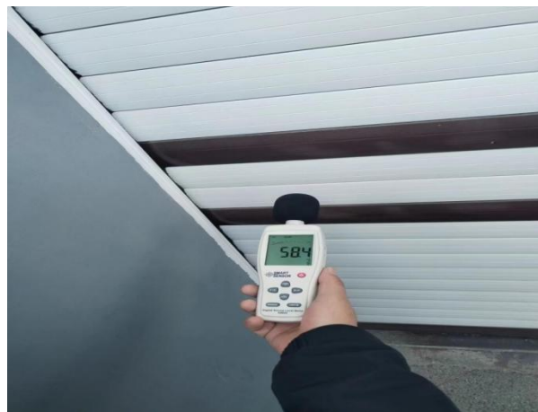
空压机安装在物理设施内-外部噪音检测
