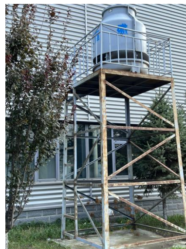
设备配备的冷却水水塔
