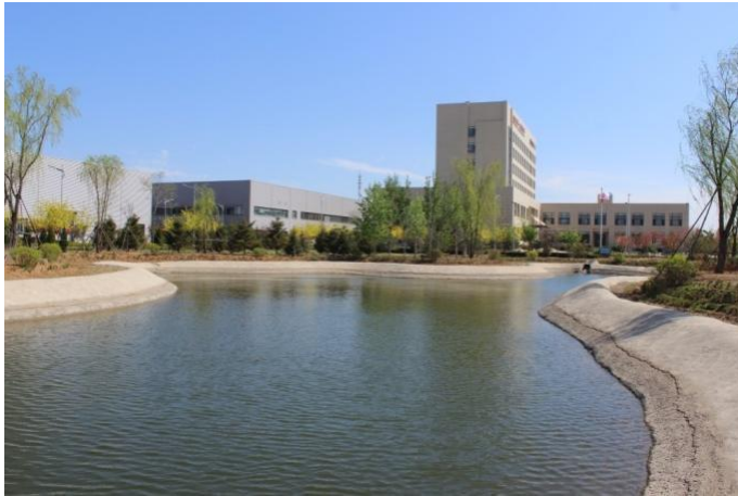
雨水池正常使用中
